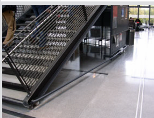
Markering av høye hindre på gulvnivå
