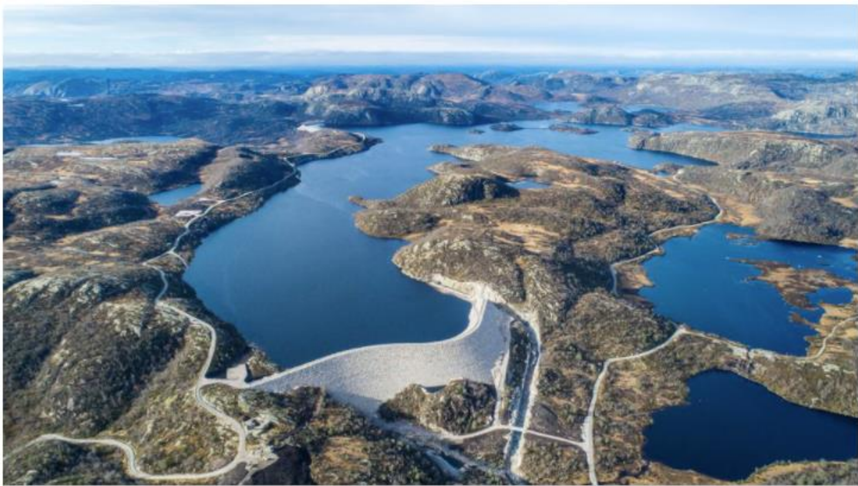
Dam Skjerkevatn i Åseral.
